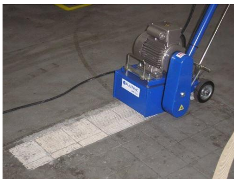
Fraisage du béton
