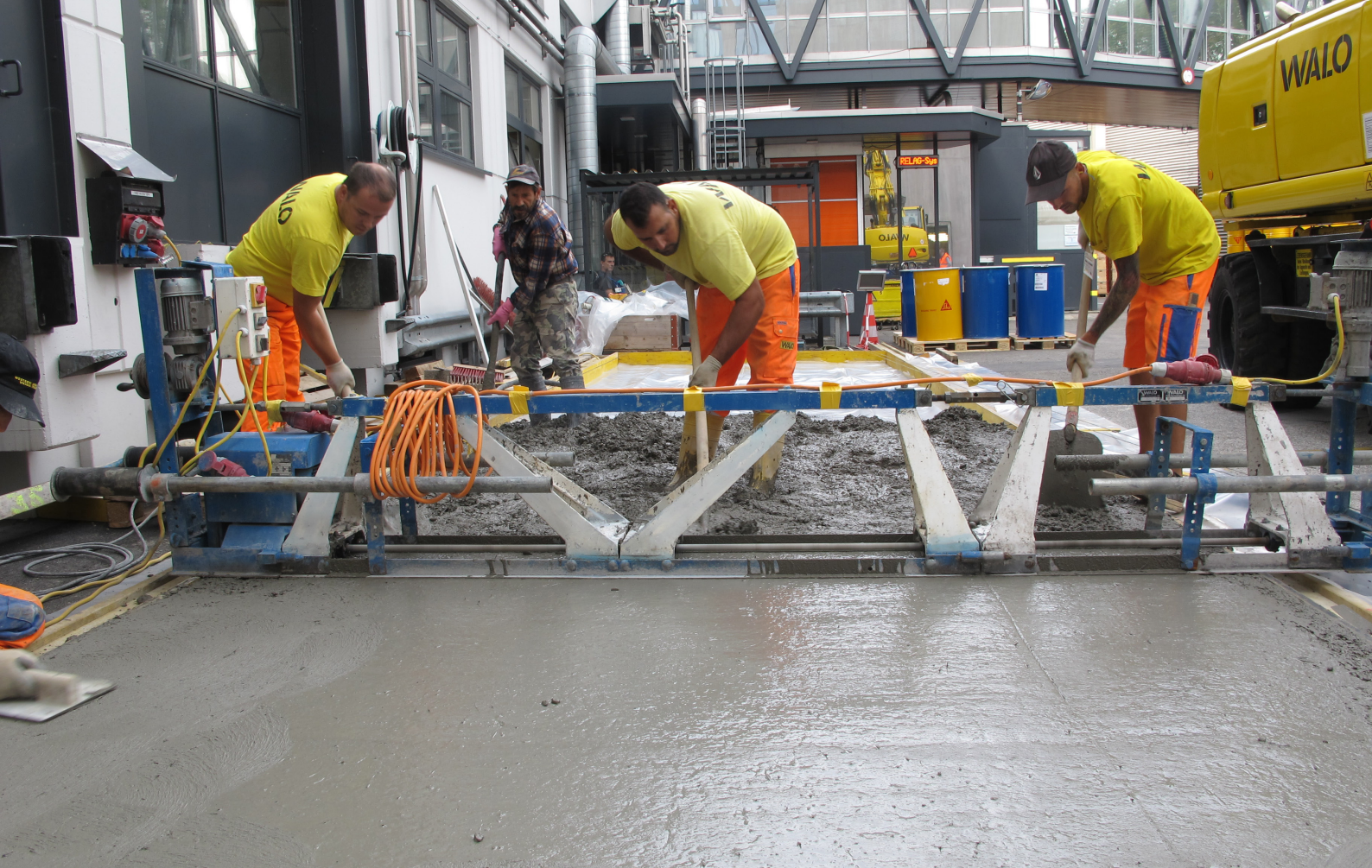
Les fibres sont utilisées pour améliorer la tenue en fatigue du nouveau revêtement en béton.
