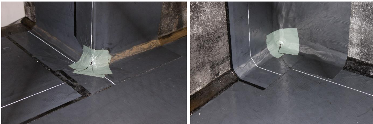
Afbeelding 9. Sika-tape als extra patch voor de hoekverbinding
