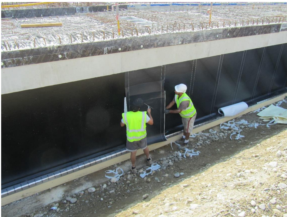
Afbeelding 2. Achteraf aangebracht bitumineus membraan op keermuren (verticale toepassing)
