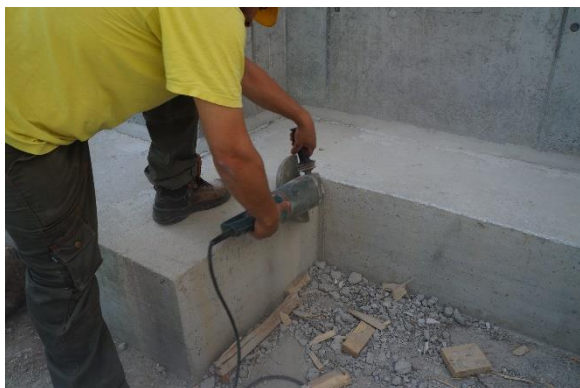
Afbeelding 3. Voorbereiding van de ondergrond
