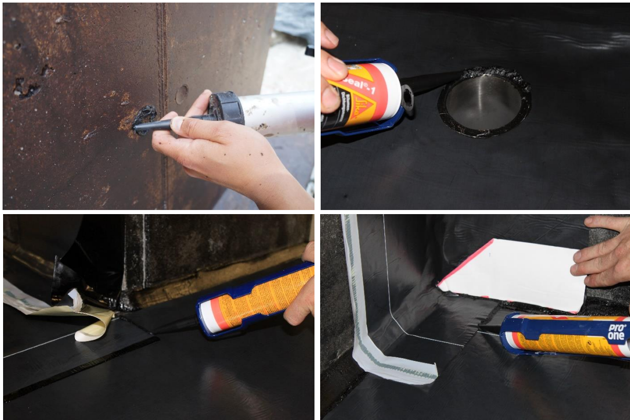
Afbeelding 8. SikaSeal 173 voor het afdichten van de details en T-verbindingen
