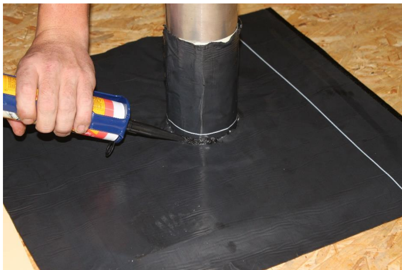
Afbeelding 9. Bitumineus afdichtmiddel dat de verbinding tussen de membranen sluit
