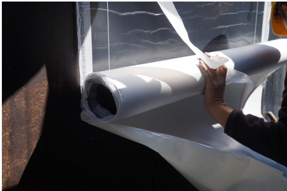
Afbeelding 7. Aanbrengen van het zelfklevende membraan met de overlap markering in het wit.
