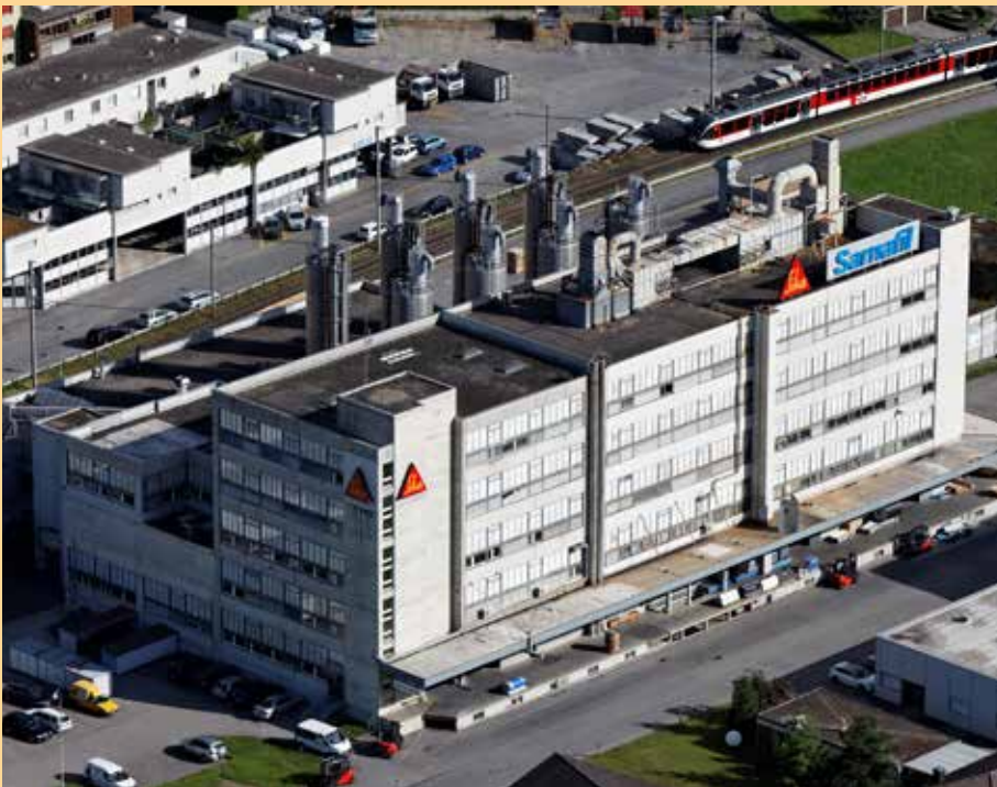
Het eerste Sarnafil® T dakafdichtingssysteem uit 1988 (Sarnen, Zwitserland).
