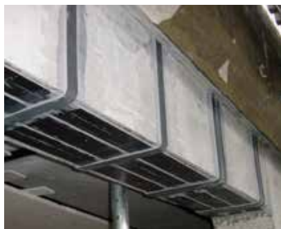
VERSTERKEN VAN BALKEN
