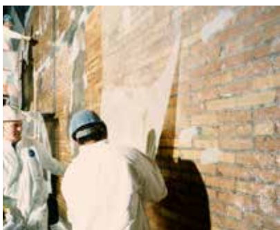
AARDBEVINGBESTENDIG MAKEN/ AARDBEVINGSSCHADE REPAREREN
