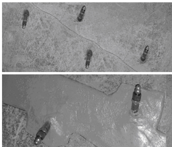
Figure 1: supports d'injecteurs type douille placés autour de la fissure et bouchés avec un colle époxydique approprié de la gamme Sikadur®.
