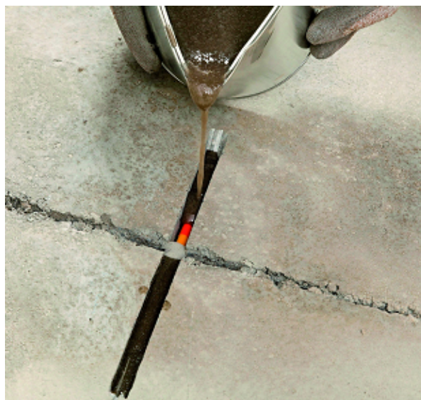
Figure 6: remplir les canaux d'agrafes et les fissures avec le mélange SikalInject®-1360.
