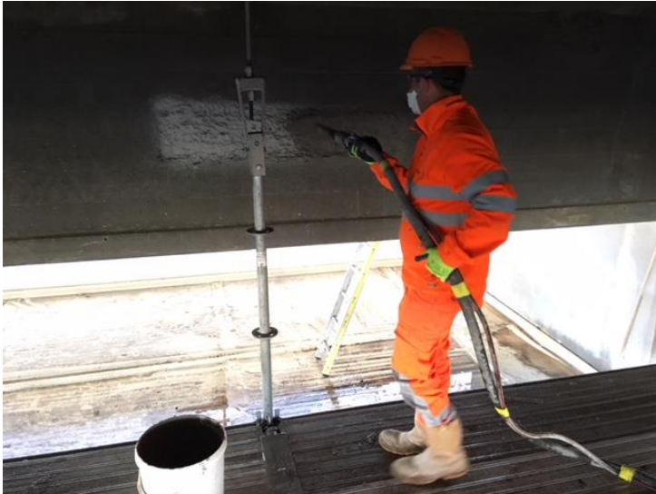
Figure 9. Application par pulvérisation de Sika MonoTop®-4012
