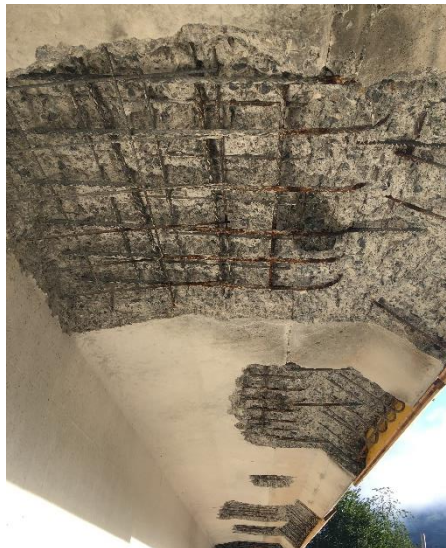
Figure 1. Préparation du support par enlèvement du béton à l'eau sous haute pression et mise en place du coffrage (en bas à droite)
