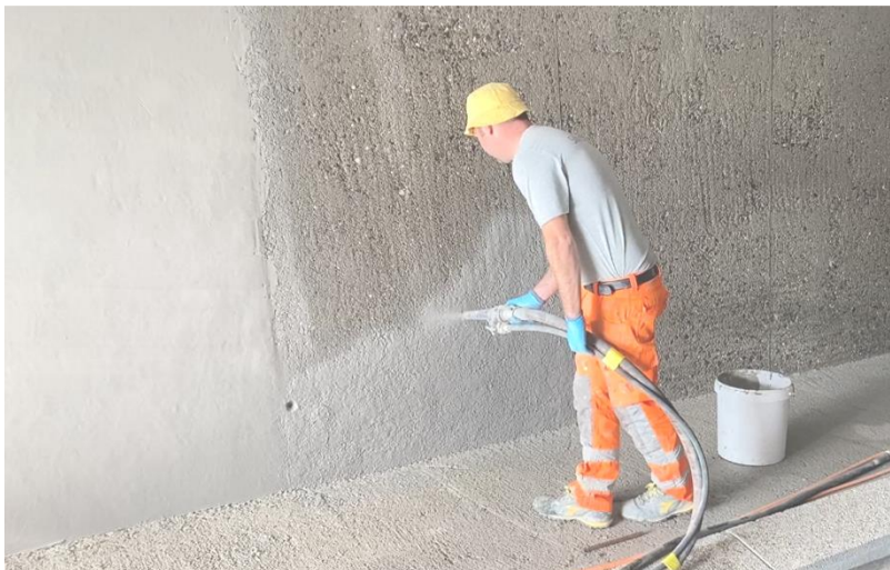
Figure 10. Application de Sika MonoTop-3020 par pulvérisation et application manuelle
