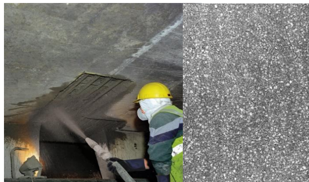
Figure 6. Mortier appliqué à la machine. Application plus dense.
