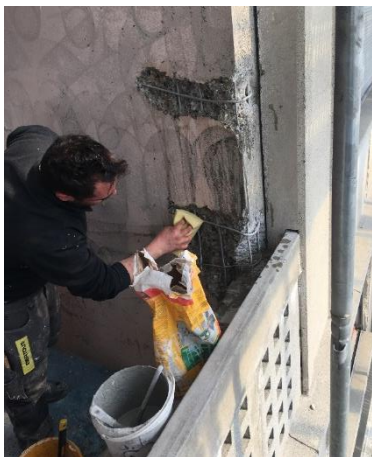
Figure 2 Pré-humidification avec une éponge
