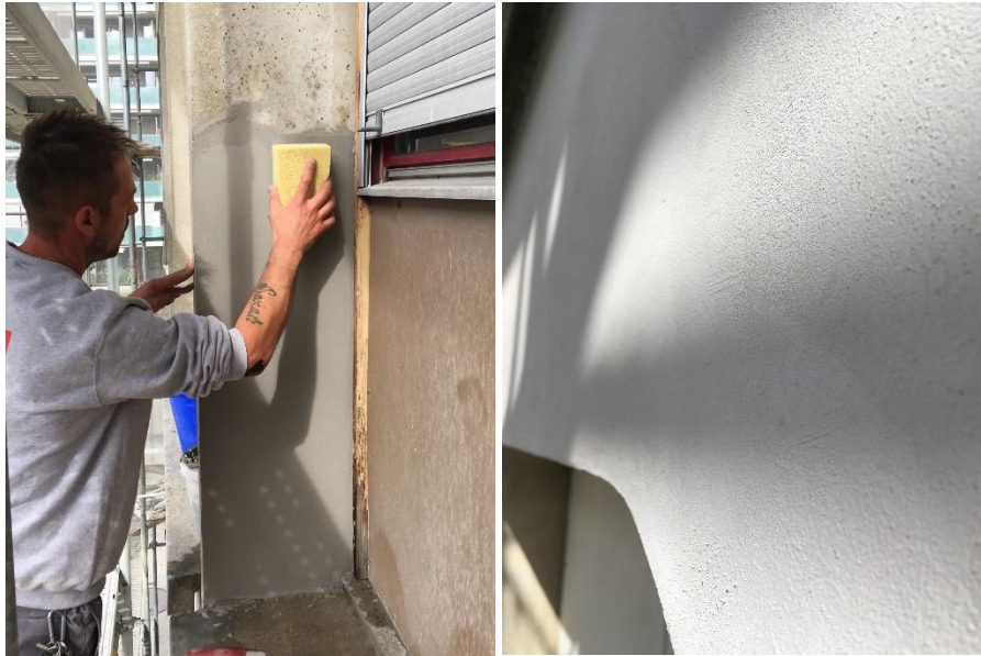
Figure 11. Finition du mortier de nivellement Sika MonoTop®-3020 avec une éponge
