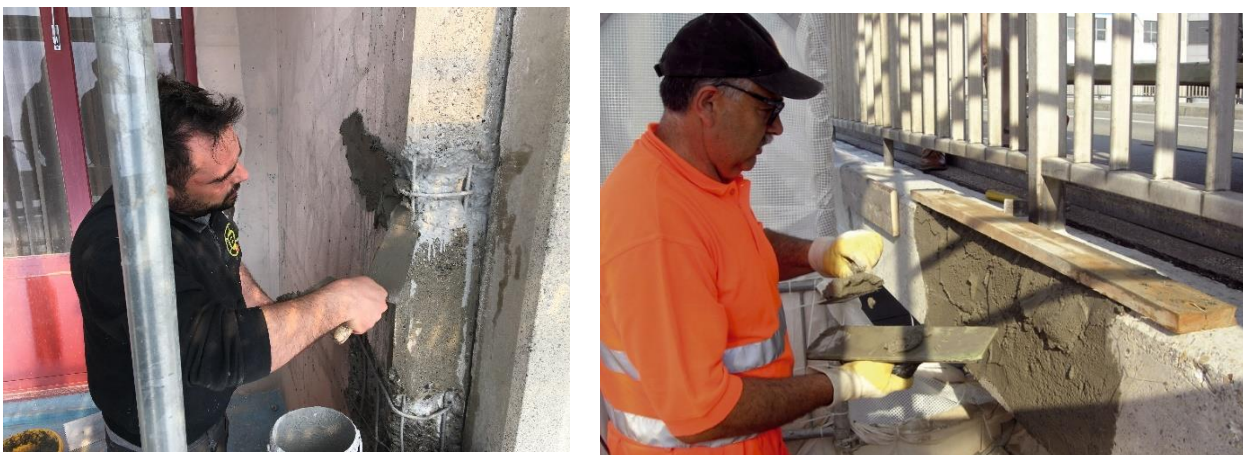
Figure 8. Application manuelle du mortier de réparation Sika MonoTop®-4012
