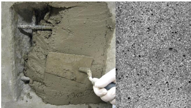
Figure 7. Mortier appliqué à la main
