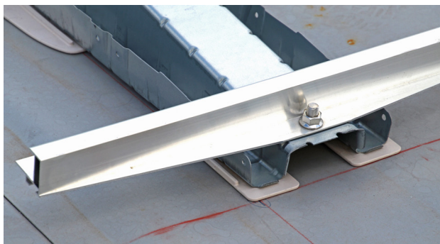
Monteer positionering langs de krijtlijnen
