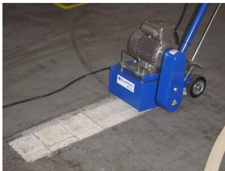
Het beton opbreken
