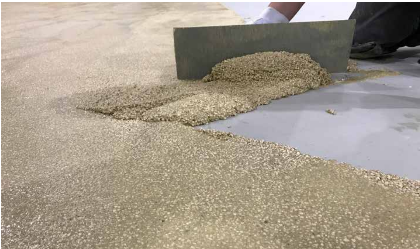
Le Sikafloor® PurCem® HM-20 HSR est un système texturé, applicable à la truelle, qui présente une résistance élevée au glissement. L'application typique se fait avec une truelle ou "screed box."
