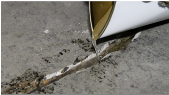
Figuur 4: SikalInject®-1360 rechtstreeks in de V-vormige groeven van de scheuren gieten. Indien er ter plaatse geen gebruiksklaar materiaal voor de afdichting beschikbaar is, bereidt u een mengsel van SikalInject®-1360 met droog, schoon kwartszand en vult de groeven met dit mortelmengsel, zie figuur 5.
