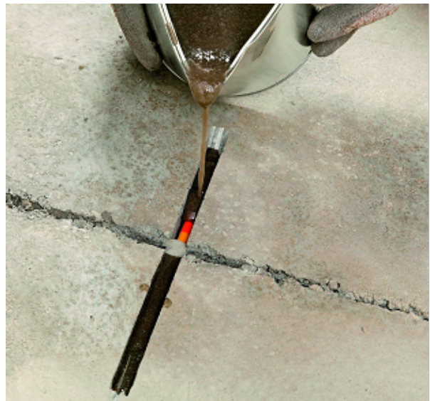
Figuur 6: de kanalen voor de dekvloerdwarsliggers en de scheuren vullen met het SikalInject®-1360 mengsel.
