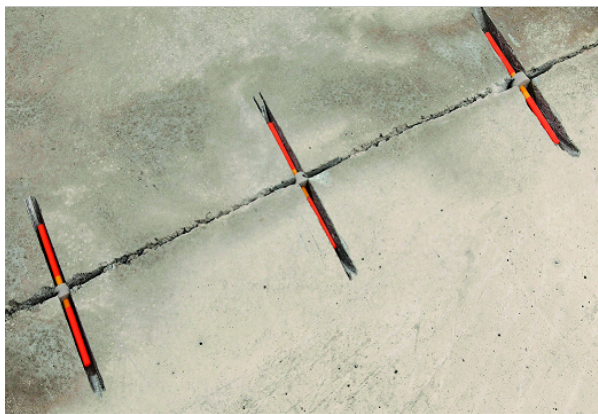
Figuur 3: plaatsing van de dekvloerdwarsliggers in de kanalen die in de scheuren zijn gemaakt.
