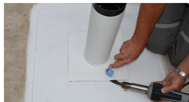
Souder la pièce d'enveloppe préfabriquée Sika® puis contrôler la qualité de l'ensemble.
