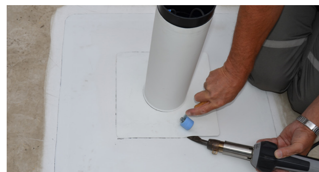
Dichtlassen van de Sika® prefab doorvoermkleding en vervolgens nacontrole uitvoeren.
