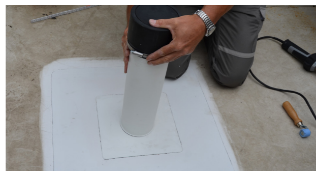
De afdekkap met geïntegreerde warmte-isolerende kern plaatsen.
