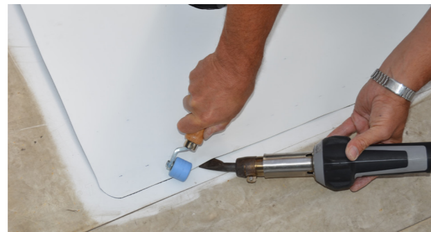
Het oppervlak passend maken en vastlassen.
