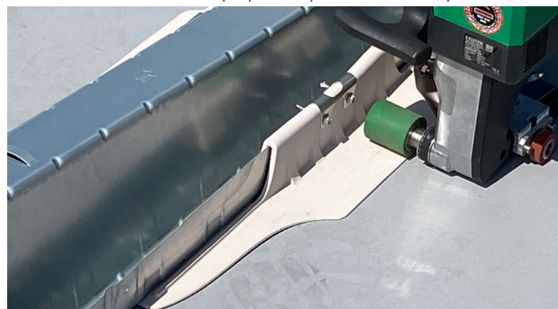
Soudage à l'air chaud d'une bride à cliquet SarnaRoof® avec une machine de soudage semi-automatisée
