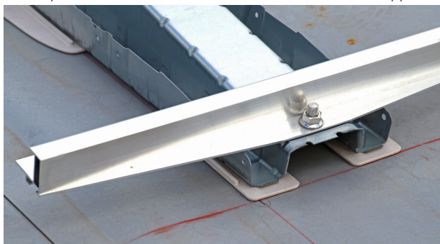
Monter le positionnement le long des lignes de craie
