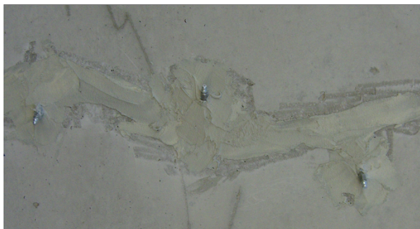
Figuur 1: busvormige nippels geplaatst rond de scheur en afgedicht met een aangepaste epoxylijm uit het Sikadur® gamma.
