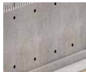
SikaSwell® Rings & Plugs Sikadur® 31 Afdichting van verankerings- gaten
