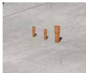
SikaSwell® Afdichten van servicetoegan- gen en doorvoeren
