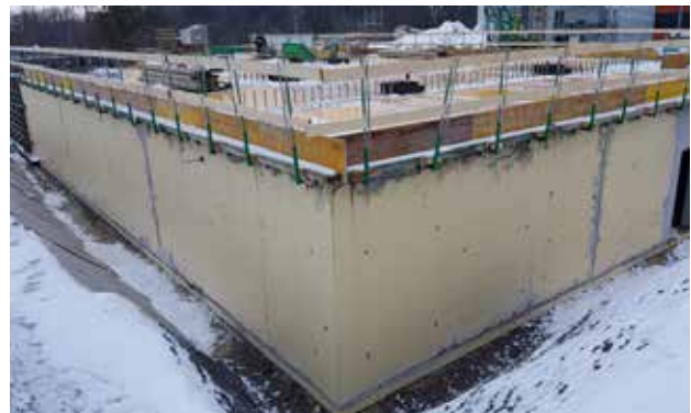
Excavation à ciel ouvert SikaProof® A+ : après avoir enlevé le coffrage il faut sceller les pénétrations d'ancres.
