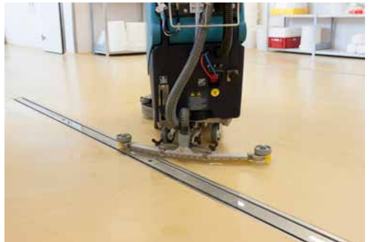
Sikafloor® PurCem® HM-20 in een ijsfabriek.
