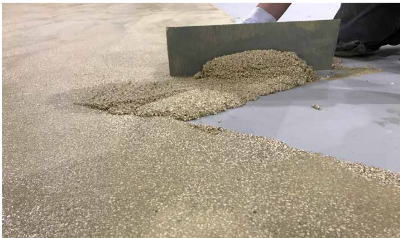
Sikafloor® PurCem® HM-20 HSR is een getextureerd, troffel-grade systeem met hoge slipweerstand. Typische applicatie wordt gedaan met een troffel of "screed box".
