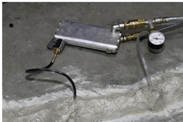
Fig. 3 Injection de SikalInject®-1380 à l'aide d'une pompe à 2 composants pour réparer un sol en béton.
