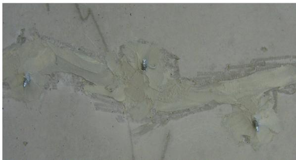
Figure 1: supports d'injecteurs type douille placés autour de la fissure et bouchés avec un colle époxydique approprié de la gamme Sikadur®.
