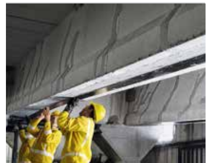
ÉVITER/RÉDUIRE LES FISSURES
