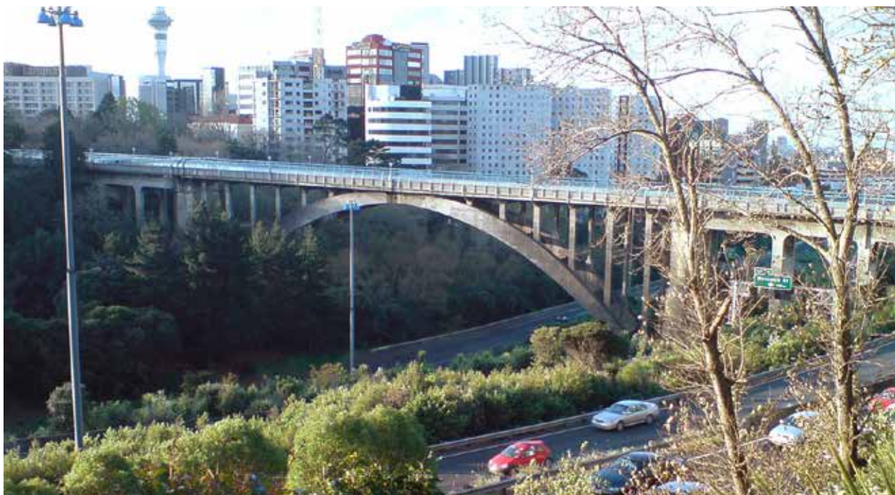
Pont de Grafton, Auckland, Nouvelle-Zélande
