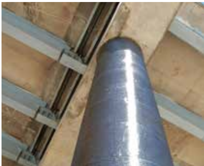
RENFORCER DES COLONNES
