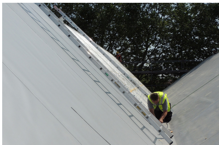
Om veilig en efficiënt te werken gebruiken dakdekkers speciale, op maat gemaakte ladders.
