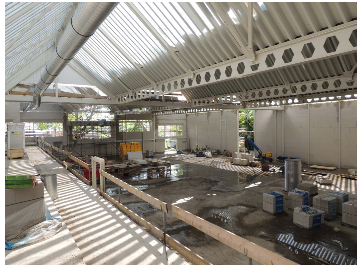
De kappen van de sporthal en andere ruimtes worden akoestisch uitgevoerd. In de cannelures van de geperforeerde geprofileerde stalen dakplaten komt geluiddempende minerale wol. Het dak van de sporthal wordt voorzien van drie ramen van 2900 bij 1750 mm.
