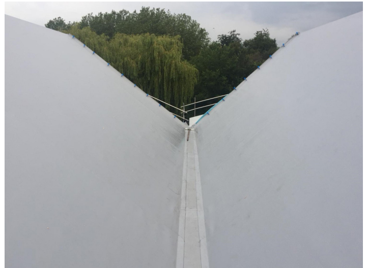
In totaal wordt ongeveer 3.450 m 2 bedekking aangebracht.
