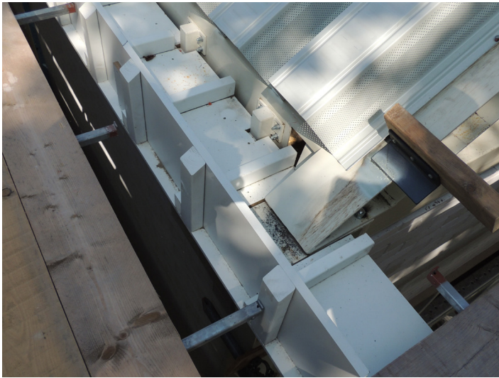
Hemelwater gaat via de verholen goten richting afvoeren in de spouwen.
