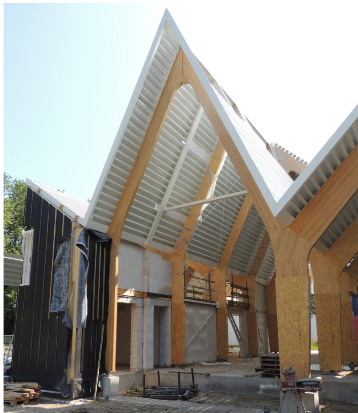
Het dorps huis is met mens- en milieuvriendelijke materialen gebouwd. Gelamineerde houten spanten, die in zicht blijven, ondersteunen het dak.
