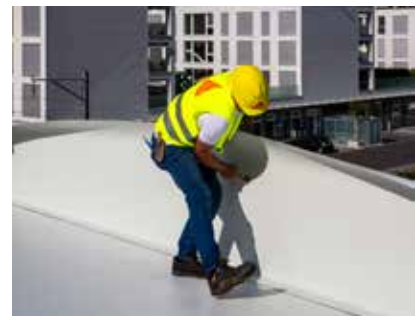
3. Bevestig het zelfklevende membraan.
