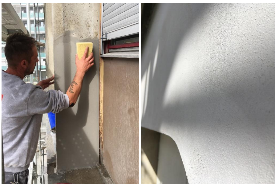
Afbeelding 11. Het afwerken van de nivellerende mortel Sika MonoTop® -3020 met een spons
