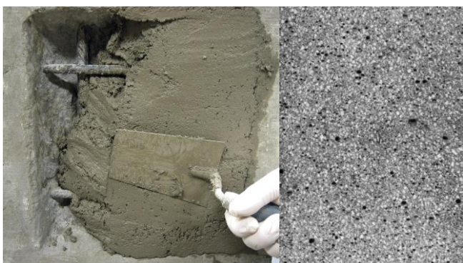
Afbeelding 6. Manueel aangebrachte mortel
