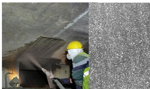
Afbeelding 7. Machinaal aangebrachte mortel. Betere compactering.
