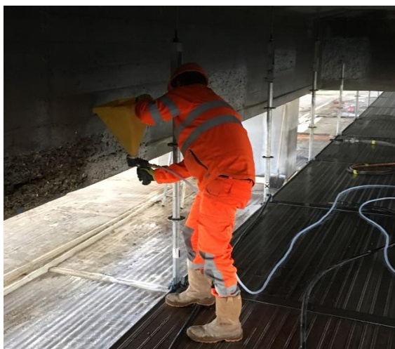
Afbeelding 5. Aanbrengen van lijmpriemer Sika MonoTop® -1010 met trechterpistool
