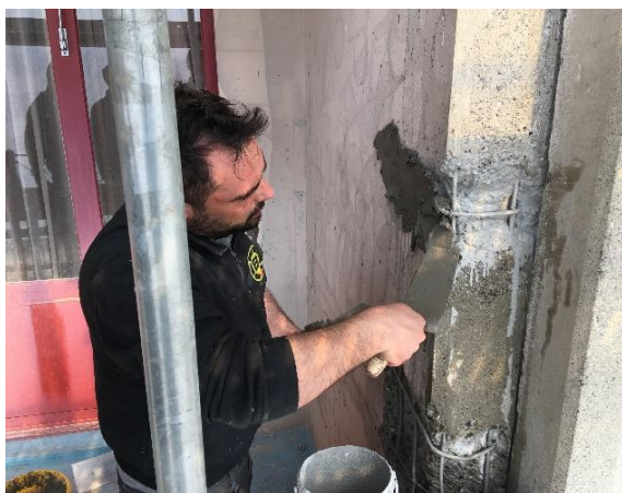
Figuur 8. Manuele toepassing van reparatiemortel Sika MonoTop®-4012
