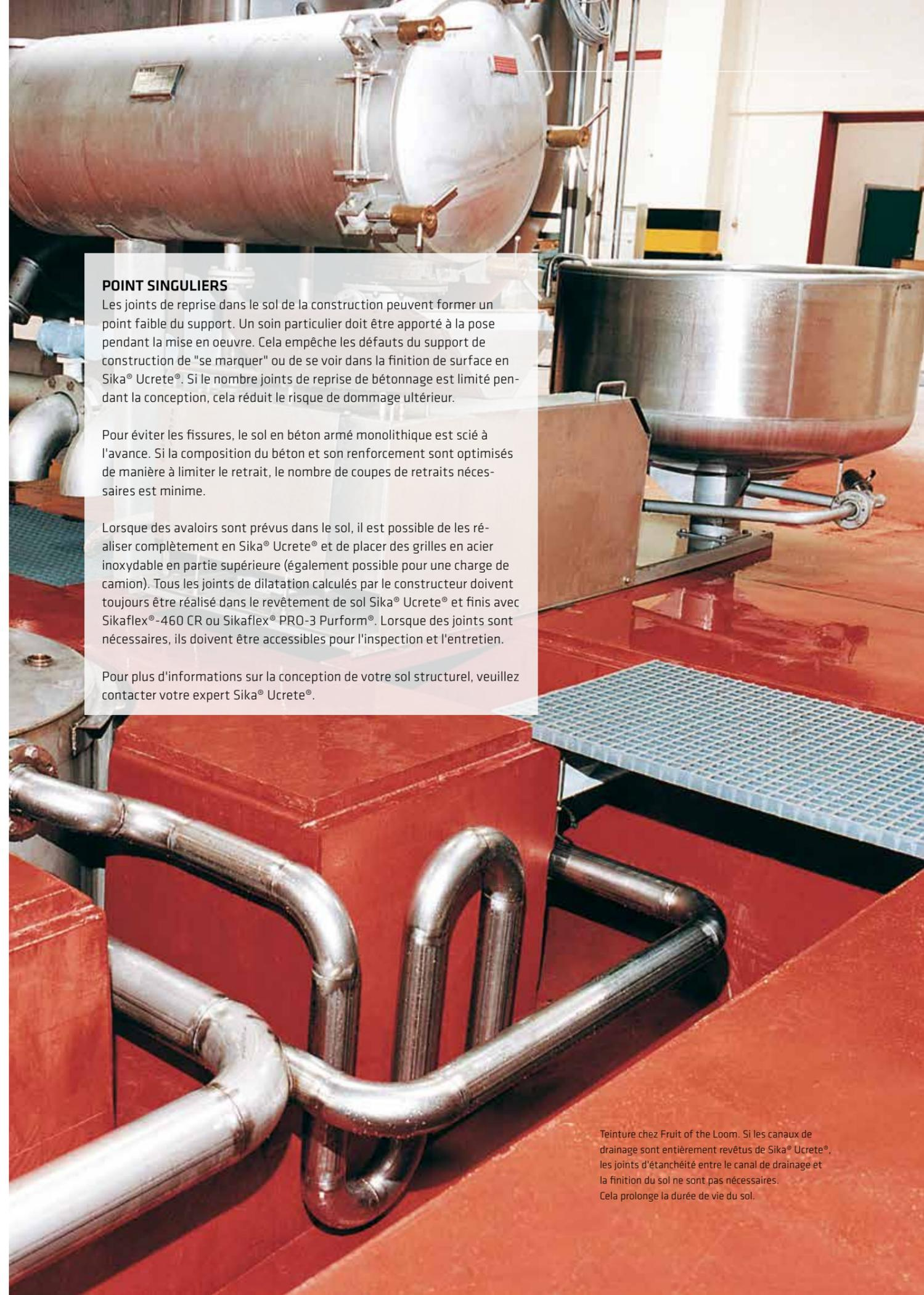
Teinture chez Fruit of the Loom. Si les canaux de drainage sont entièrement revêtus de Sika® Ucrete®, les joints d'étanchéité entre le canal de drainage et la finition du sol ne sont pas nécessaires. Cela prolonge la durée de vie du sol.
