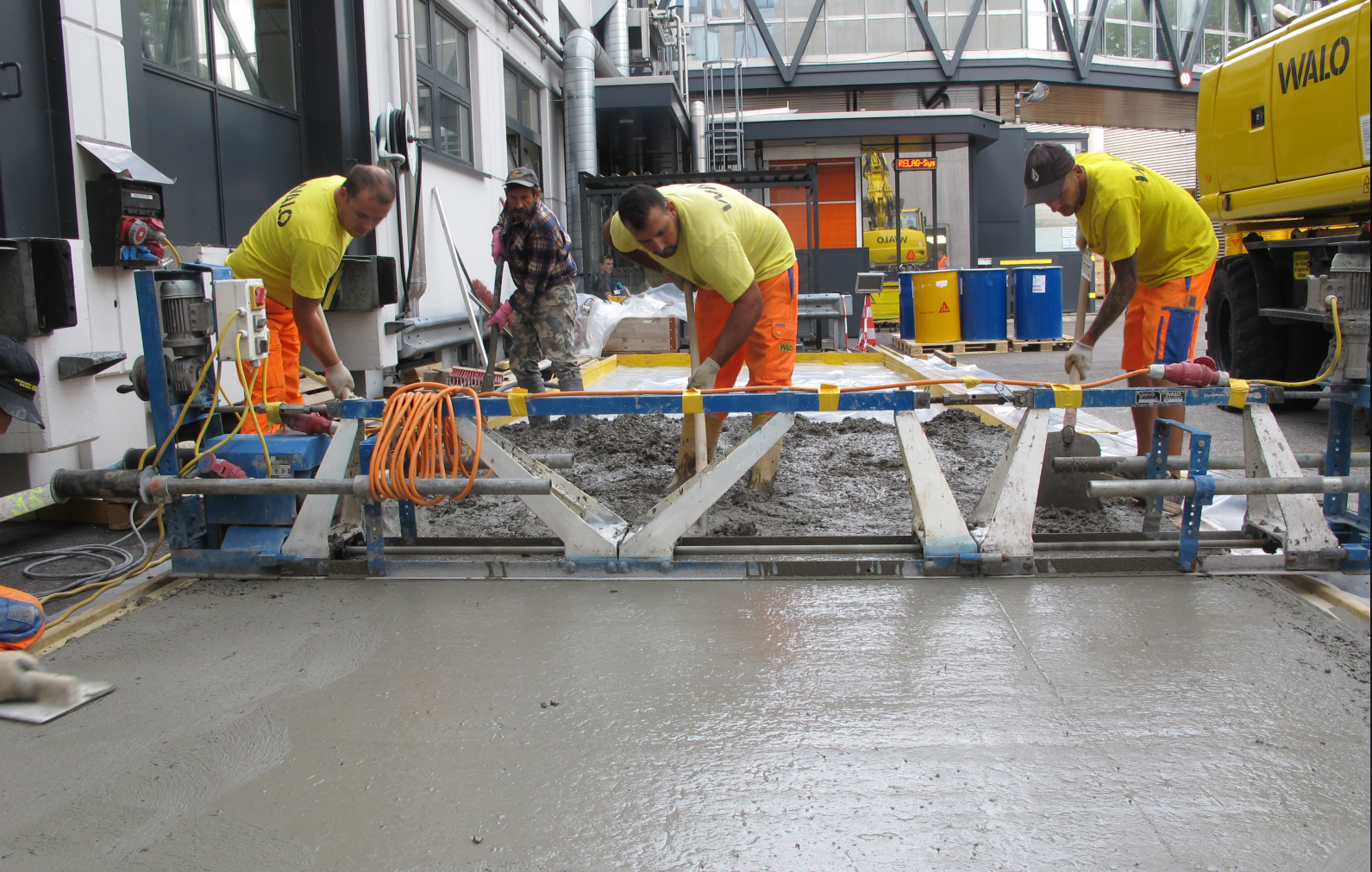
Vezels worden gebruikt om het vermoeidheidsgedrag van de nieuwe betonnen bovenlaag te verbeteren.
