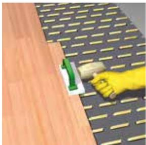
Assembler les éléments de parquet à l'aide d'un marteau ou d'un bloc d'impact. Laisser un espace de 10-15 mm entre le parquet et les murs.
