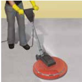
Un ponçage de la surface et un nettoyage soigneux à l'aide d'un aspirateur industriel sont très importants.
