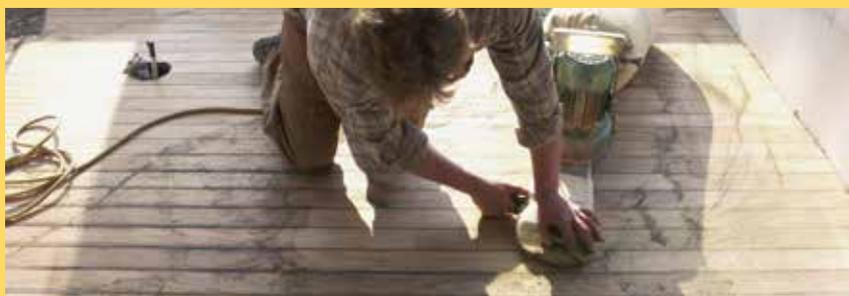
Appliquer une couche de fond de Sika® Primer-3 N dans les joints et sceller avec Sikaflex®-290i DC
