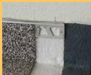
Dans le cadre de joint présentant des mouvements : appliquer un profil Schiene-A20 de chaque côté du joint et colmater l'espace entre les profils A20 avec du **Sikaflex®-11 FC Purform®**.
