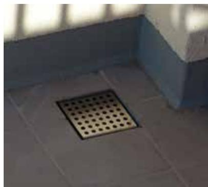
Pour ce faire veiller à créer des découpes dans la partie basse de la rehausse et ne pas la coller. Pour les grilles perforées et pliées en acier inoxydable, veiller à ne pas terminer avec des arêtes vives afin de ne pas blesser l'étancheité.
