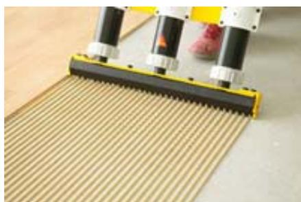
Aucun autre nettoyage / maintenance n'est nécessaire avant de commencer les travaux. Connecter simplement le tuyaux d'air et commencer.
