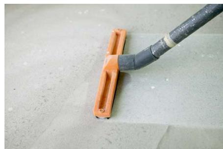
Un ponçage de la surface et un nettoyage soigneux à l'aide d'un aspirateur industriel sont très importants.
